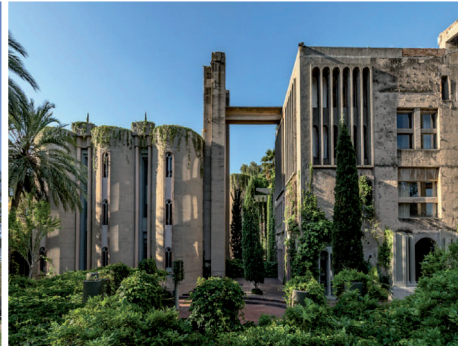
La Fabrica, reconversion d'une cimenterie, Ricardo Bofill , Barcelona, 1973 à 2022
