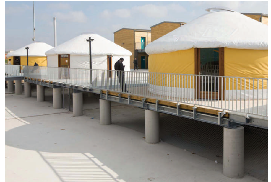
Centre d'herbergement d'urgence, Atelier Rita, Ivry sur Seine, 2017
