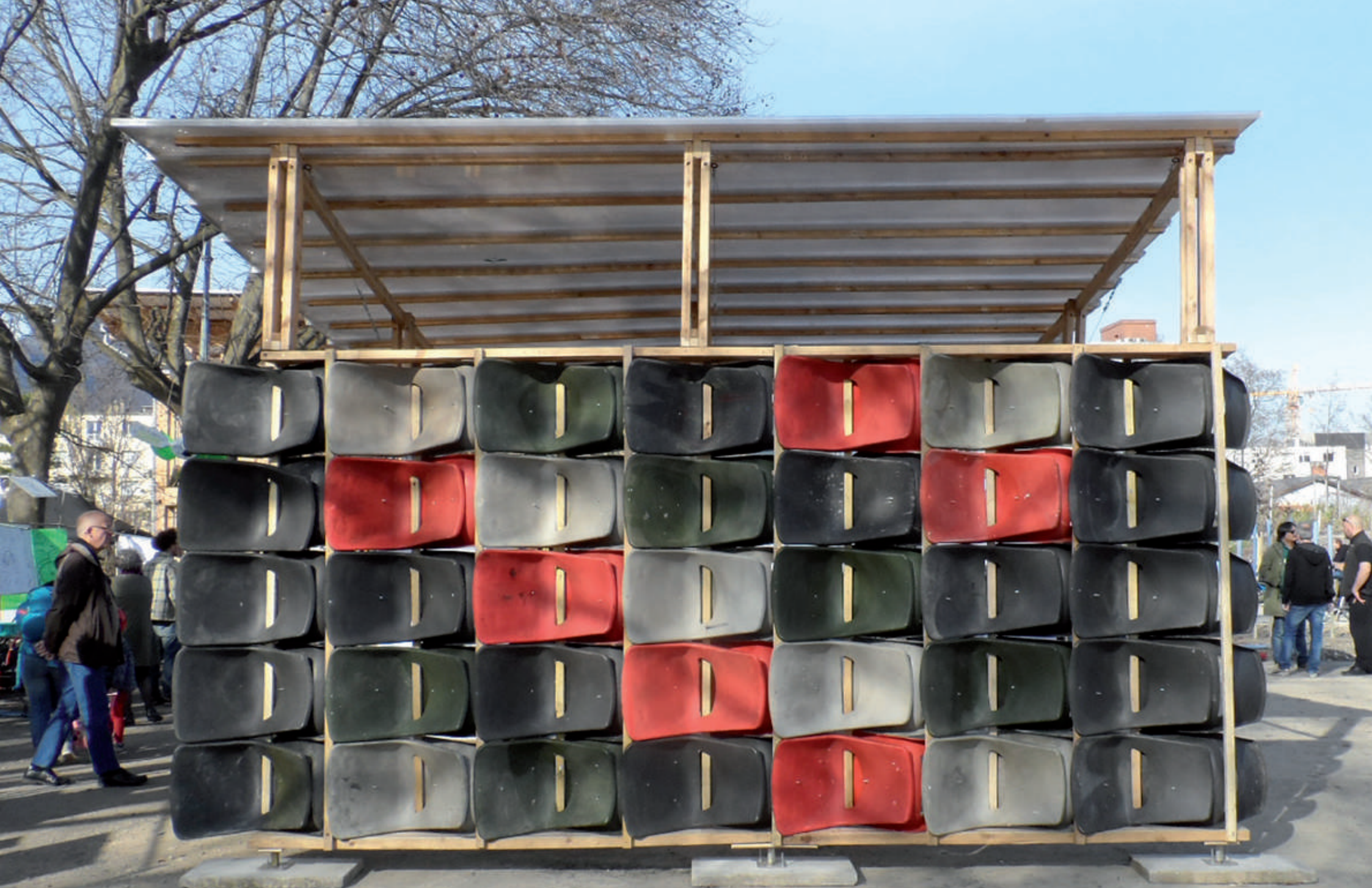
Abri vélo en éléments de réemploi - réalisé dans le cadre de l'enseignement S9 initiation au réemploi en architecture - ENSA Grenoble - 2017
