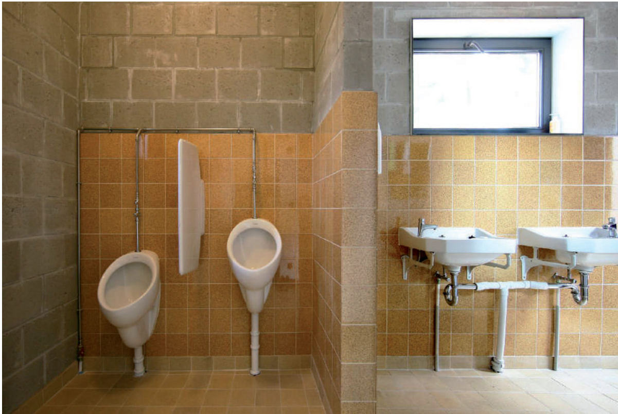
Toilettes pour le Chiro d'Itterbeek, Rotor, Dilbeek, 2019
